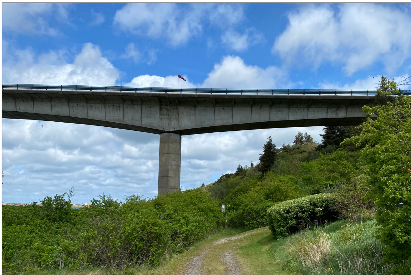
Sallingsundbroen i blæst
